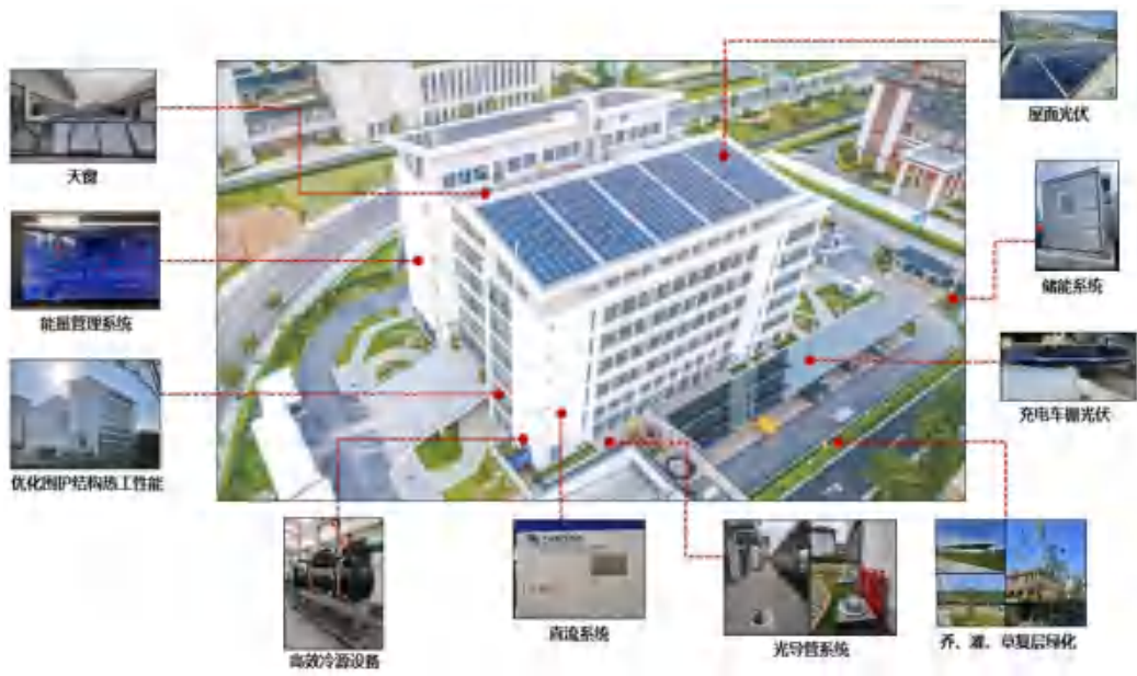
基于“光储直柔”系统的零碳建筑建设与运营技术工作原理图
